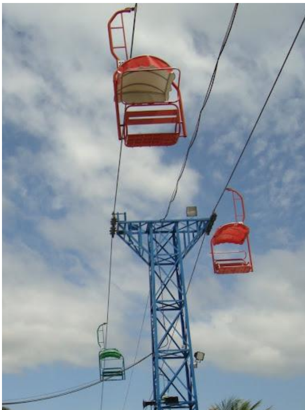
Figura 13 - Teleférico infraestrutura da Fazenda Maeda
