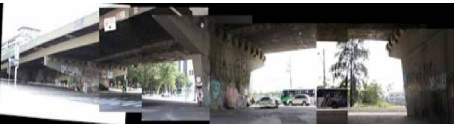
Imagem 81 [Fa]. Avenida Francisco Matarazzo e Rua Pedro Machado, em São Paulo. O registro da visão viajar. Só possível através de uma montagem fotográfica ou registro em vídeo.
