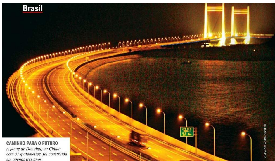
Figura 65 – Veja- Ponte de Donghai China
