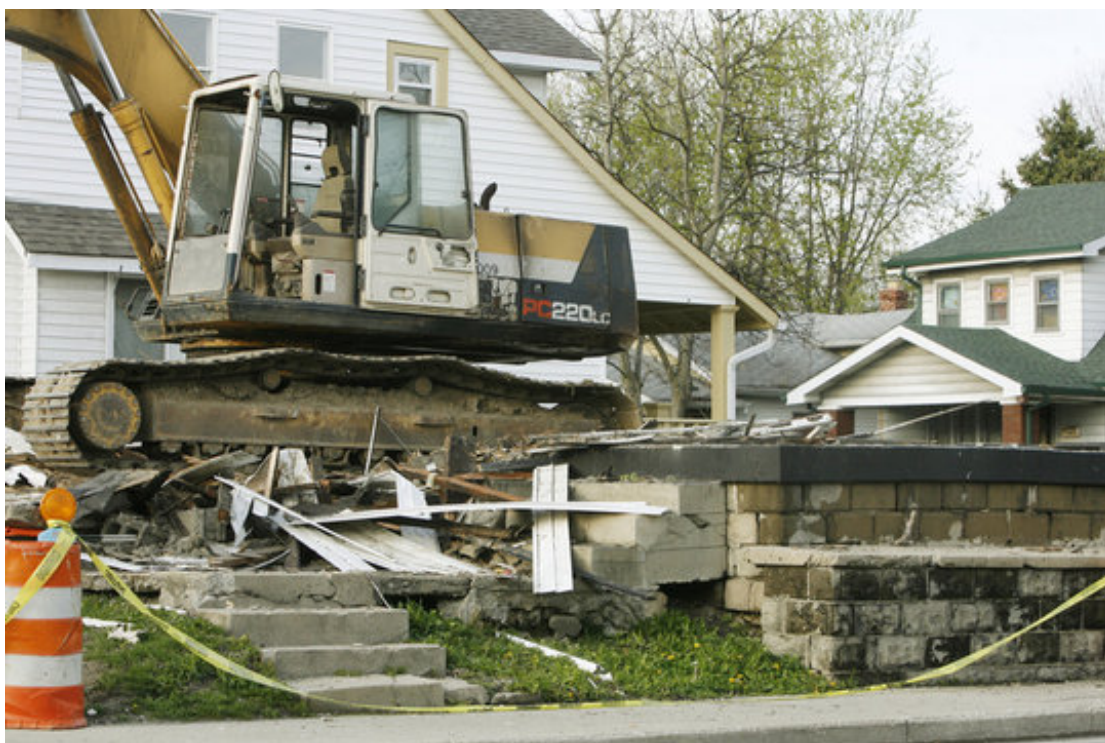
A casa é demolida em 23 de abril de 2009, após ficar fechado durante 44 anos, sem ser habitada depois do crime
