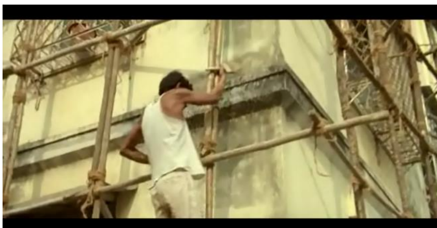
Figura 5 – Trabalhador da construção civil
